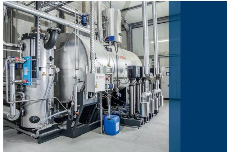
Das Wasserservicemodul mit Wärmerückgewinnung des Absalzwassers
