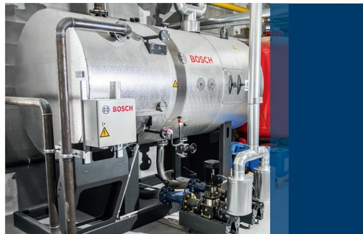
Reduzierung von Zusatzwassermengen durch das Kondensatservicemodul
