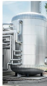
Die Abwärme der Kompressoren und Kühllhäuser wird im Wärmespeicher zwischengespeichert
