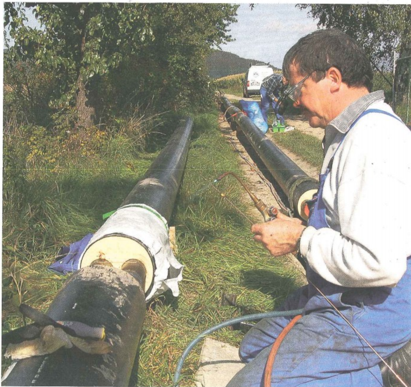
Letzte Arbeiten vor dem Anschluss ans Wärmenetz: Hubert Richter verbindet die Leitungen.
